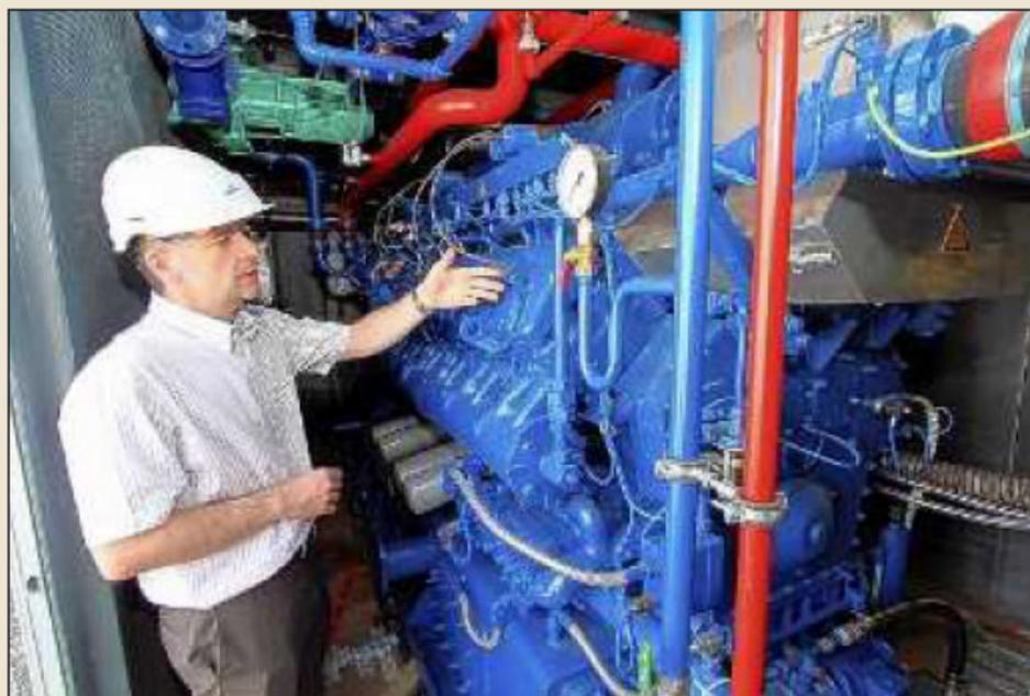
Serge Winkelmuller montre les énormes moteurs qui seront alimentés par le biogaz issu de la dégradation de nos biodéchets. Ou quand nos restes de repas deviennent gaz, puis électricité, ou chaleur.
