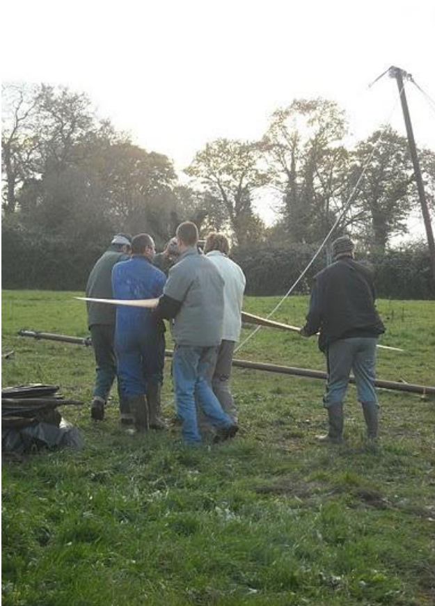
Transport des pales pour fixation sur le rotor
