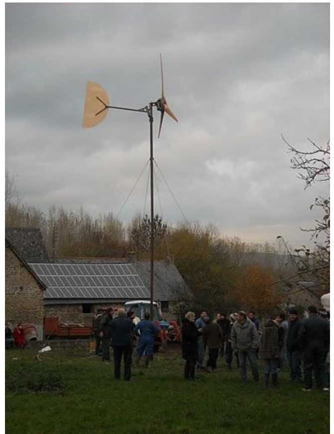
La finale l'éolienne vient d'être installé
