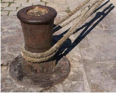
Expliquons pourquoi la tension en entrée est diminuée exponentiellement et permet ainsi d'arrêter une manœuvre sans danger à condition d'effectuer au moins un tour mort sur la borne d'amarrage ou de reprendre des tensions énormes sur un treuil en effectuant plusieurs tours avec les écoutes de voiles...
